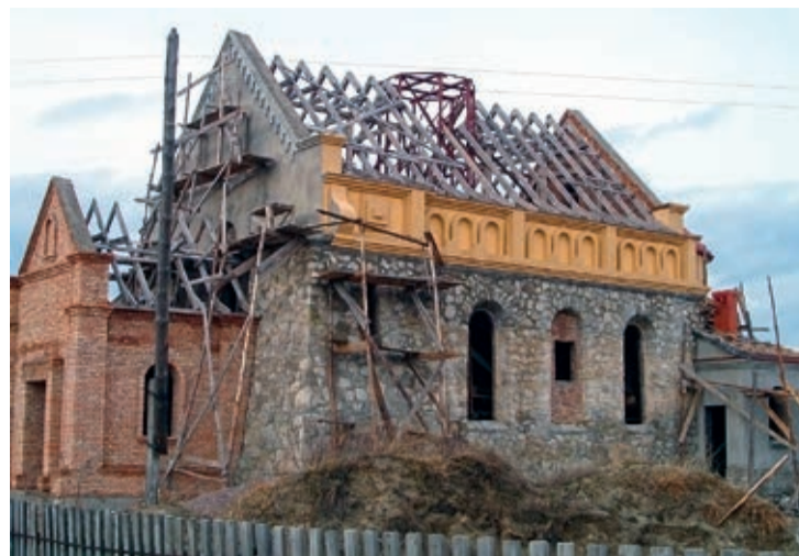
GLIŃSK, KOŚCIÓŁ W TRAKCIE PRZEBUDOWY 2007
