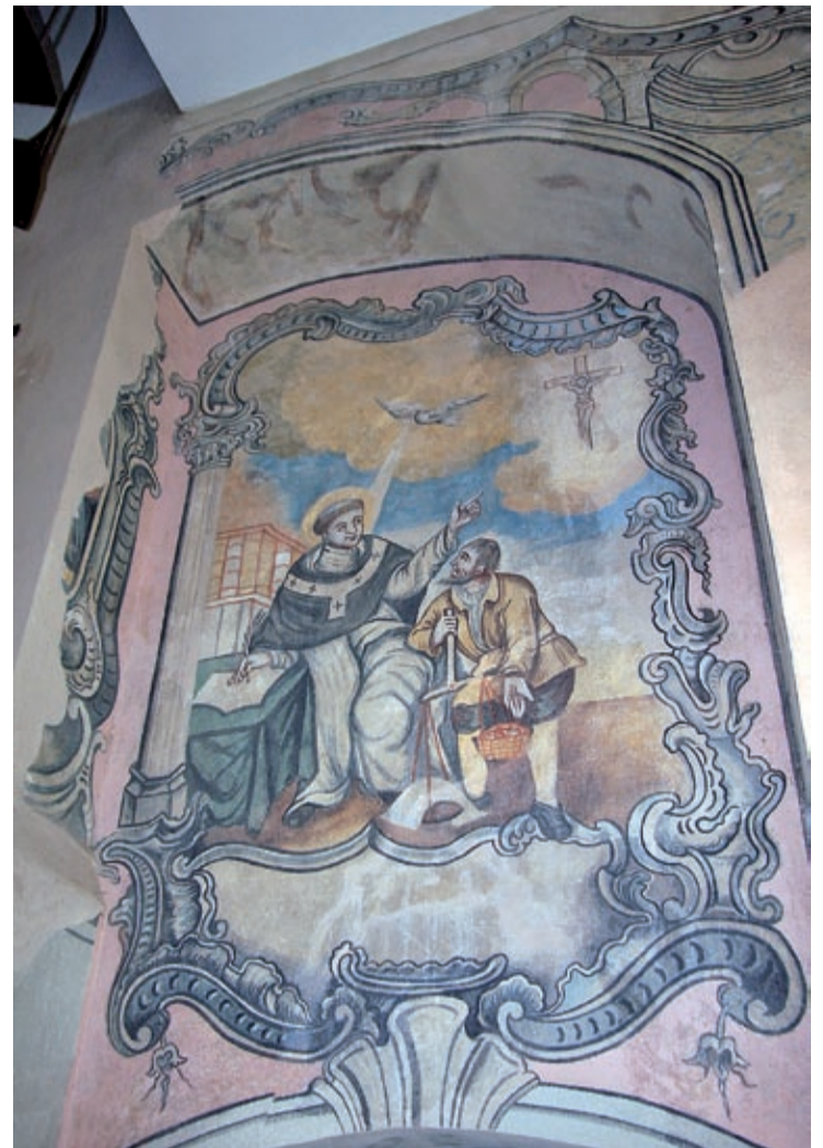
Odnowiony fresk na wieży poddominikańskiego kościoła w Belzie
