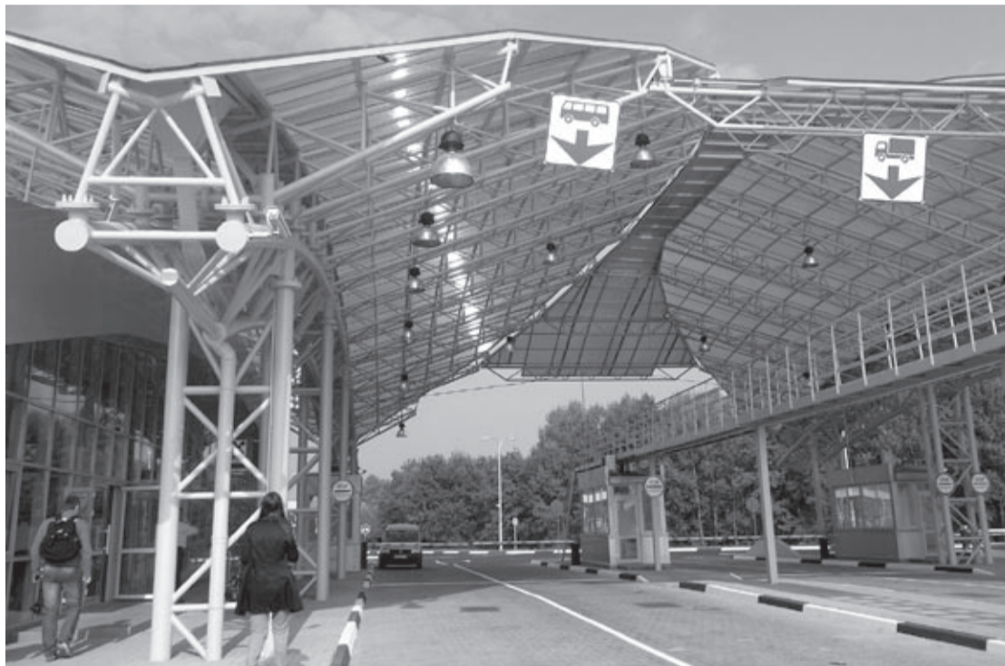
Przejście w Jagodynie jest gotowe do EURO-2012
