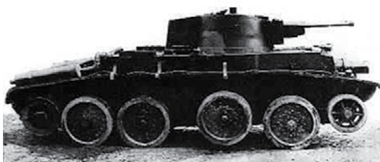
Czołg 10TP ze zdjętymi gąsienicami, przygotowany do jazdy na kołach. Widać podniesioną do góry drugą parę kół. Nie wiem natomiast, czy Państwo widzicie gąsienicę leżącą na błotniku, ustaloną specjalnymi kłami
