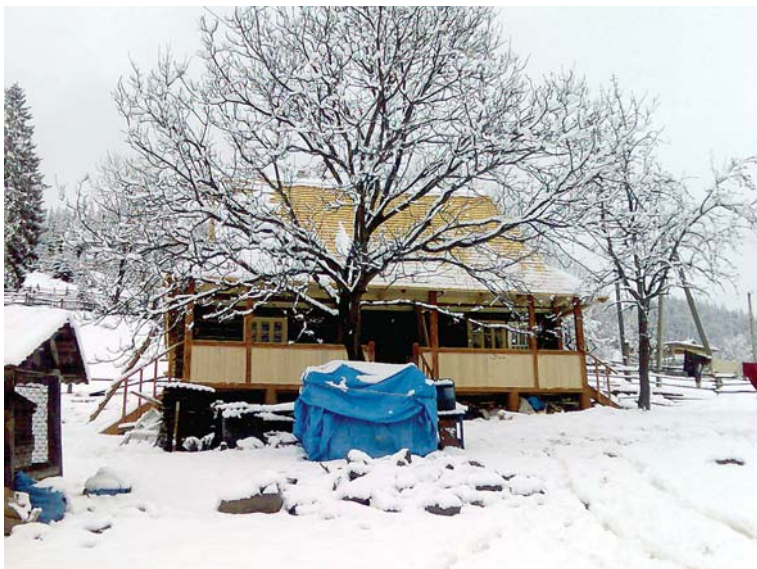
Nowy dom Barbary Stasiak w trakcie remontu
