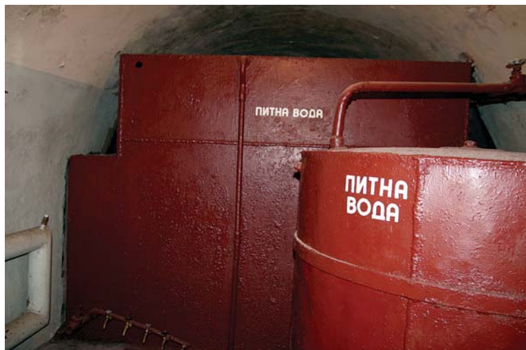
Wszystkie systemy „Obiektu” „Skała” są w stanie roboczym i mogą zostać uruchomione w ciągu 20 minut
